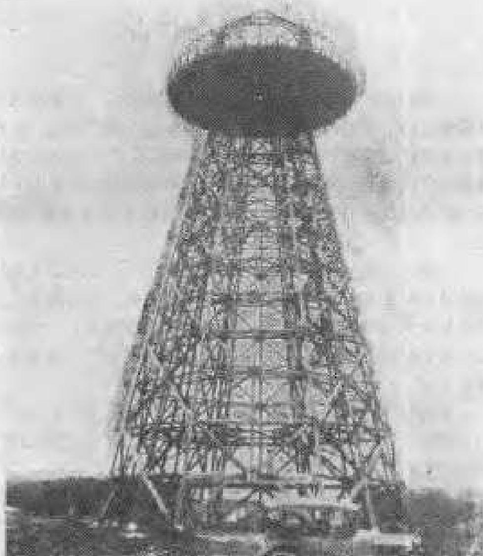
图十三 命运不佳的沃登克里弗塔，建于1901至1903年。特斯拉修建这座高塔，打算对大西洋彼岸进行无线电广播和无线传输电力
